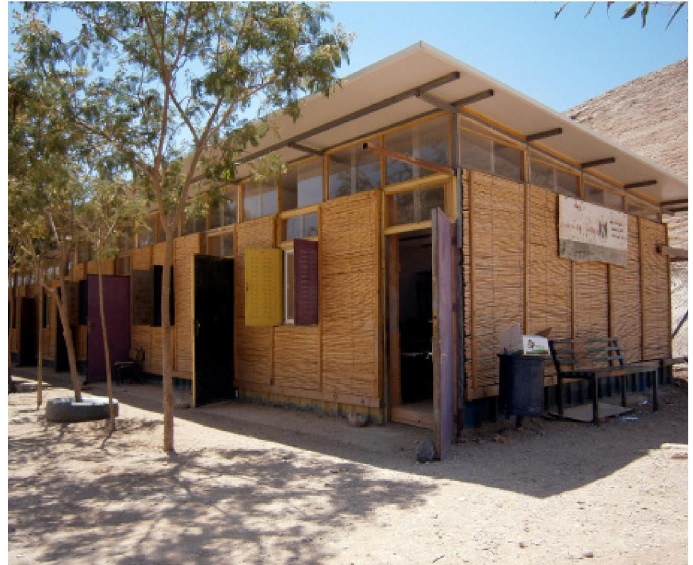
这个位于沙漠中的贝都因族群的小学原本是由金属铁板围成的简易建筑。建筑师和当地居民合作，在无法改变建筑结构的限制下，利用当地竹材、麦秆和泥土在最短的时间内将其改造成一座舒适的绿色小学
